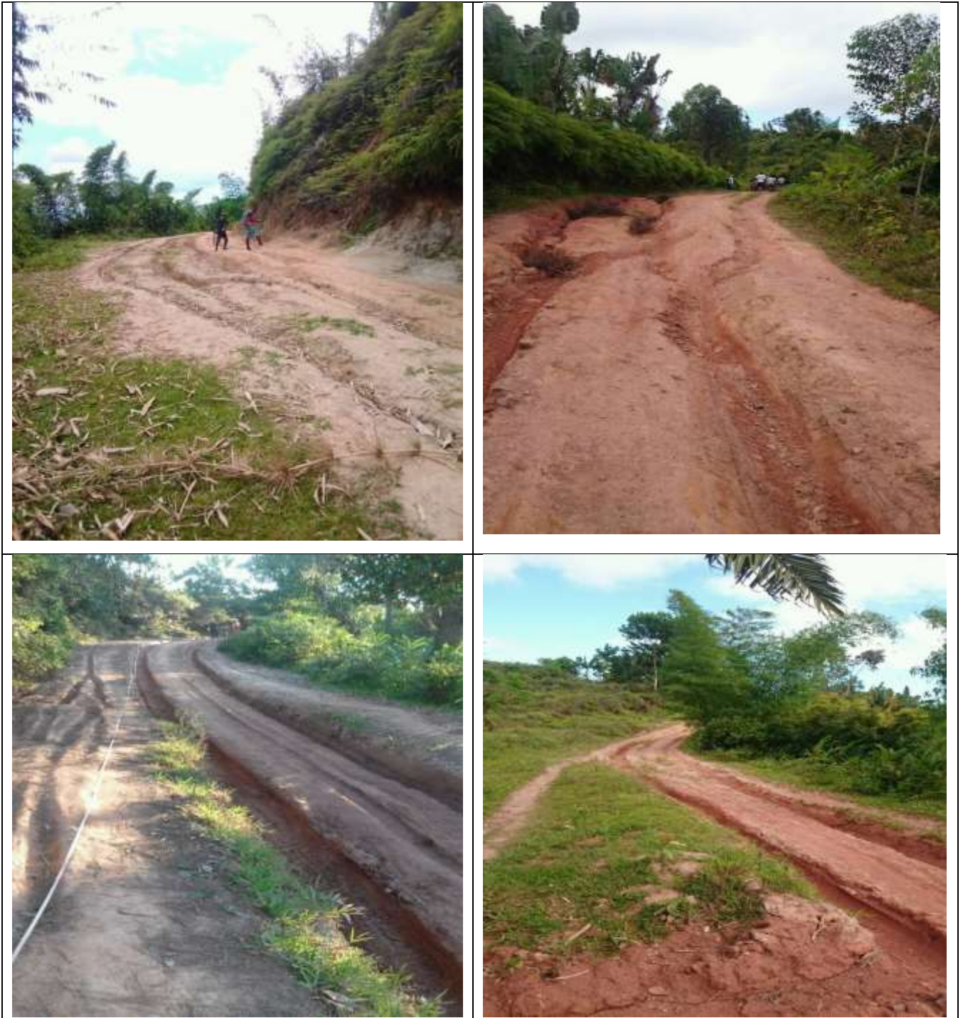
Etat actuel de la piste reliant les Communes Rurales Vohilengo - Saranambana
